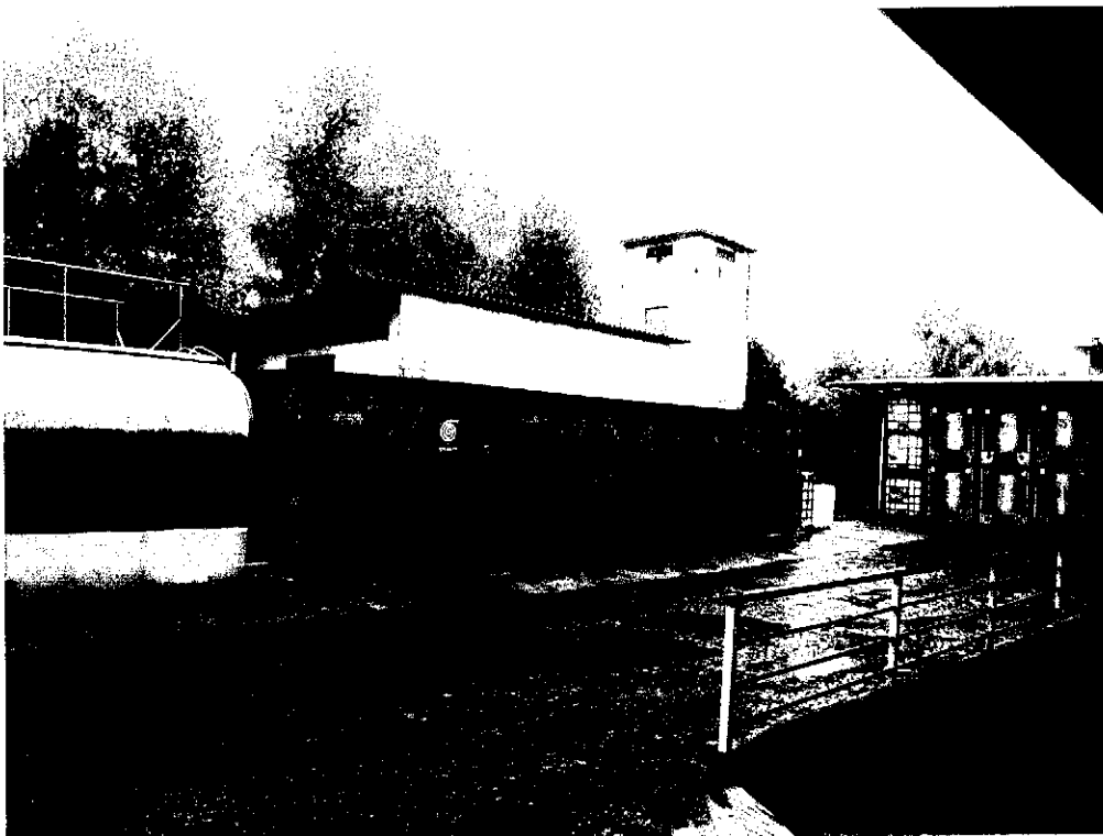
FOTO 6 - PIANO ESTERNI – vista esterna dal cortile – edificio (bunker nitrocotone)
