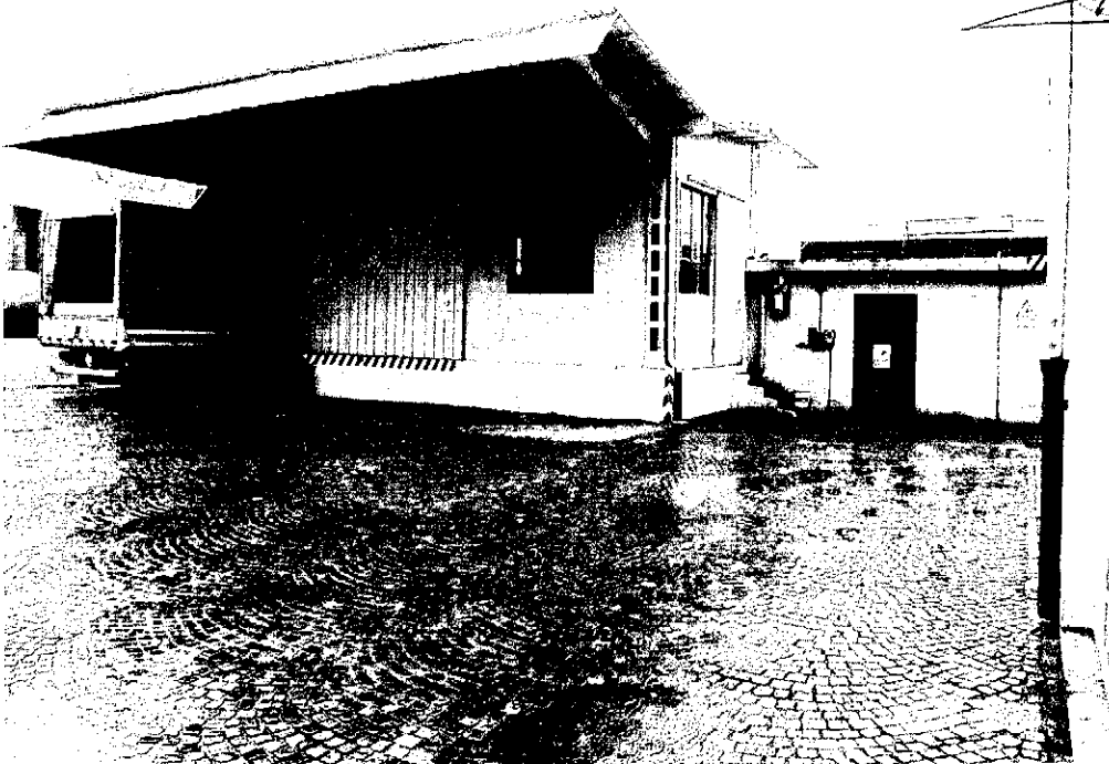
FOTO 4 - PIANO ESTERNI – vista esterna dal cortile – edificio (pompe)
