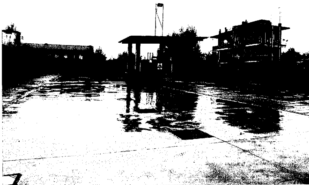
FOTO 8 - PIANO ESTERNI – vista esterna dal cortile – area cisterne interrante
