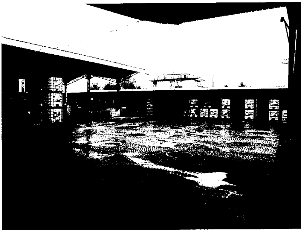
FOTO 9 - PIANO ESTERNI – vista esterna dal cortile – area cisterne interrante
